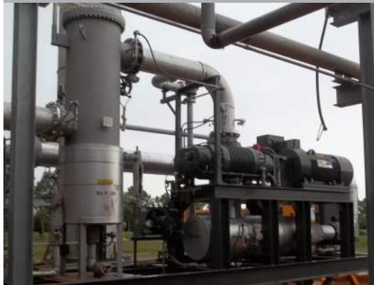
Landfill gas inlet
